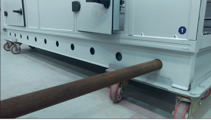
Şekil 6. Kaldırma çubuklarının bağlanması - 2
