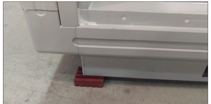
Şekil 10. Titreşim önleyici kauçuk levha
