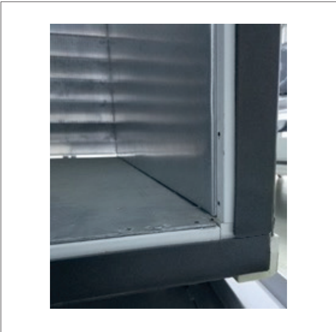
Şekil 20. İzolasyon bant uygulaması
