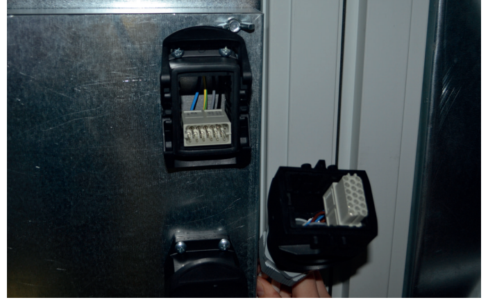
Şekil 21. Konnektör bağlantısı
