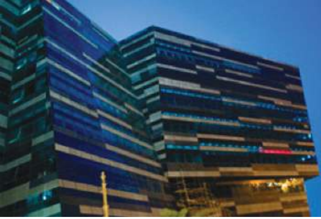
QAFCO Ofis Binası - Katar
