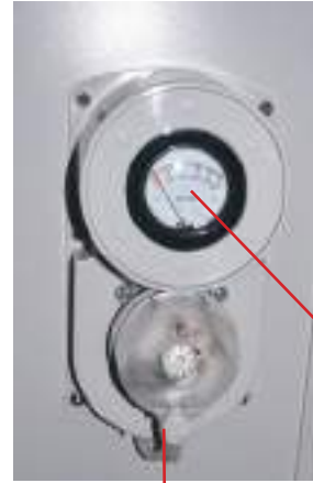
Fark basınç ölçer (Pressure Switch)
