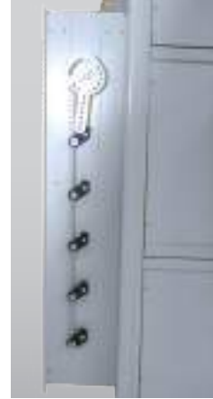
Damper hareket mekanizması
