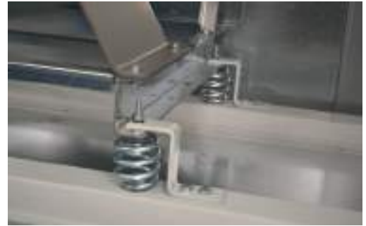
Yaylı sönümleyici (spring anti vibration mounts)
