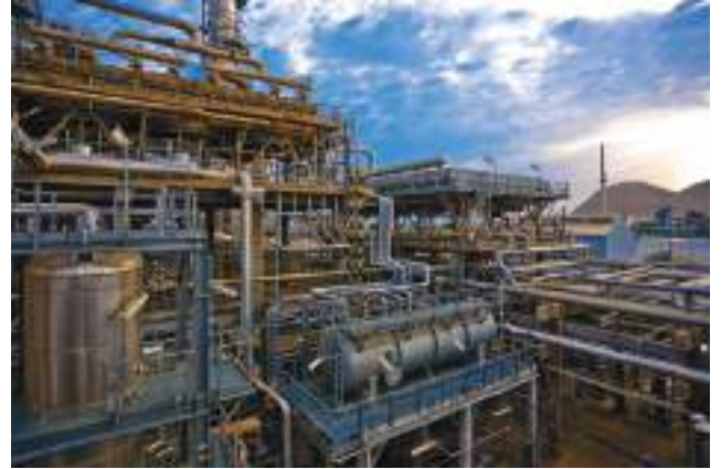
Sohar Arıtma Tesisleri - Umman
