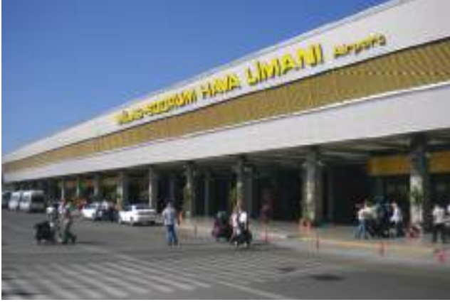
Bodrum Havalimanı - Muğla
