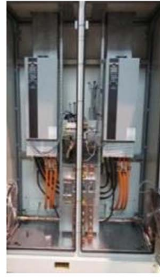
Kompresör sürücüler + ana güç bağlantısı
